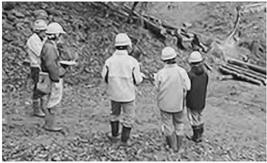
伐木造材作業現場
